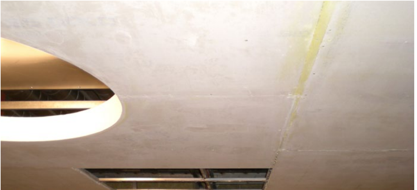
Tasaisesti levitetty liimakipsikerros, peittää keltaisen lasikuitupinnan lähes kokonaan..
