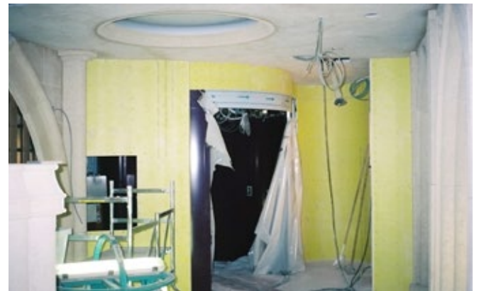
DGG-levyä voi taivuttaa asennusvaiheessa. (Taivutussäde taulukossa, s.4).
