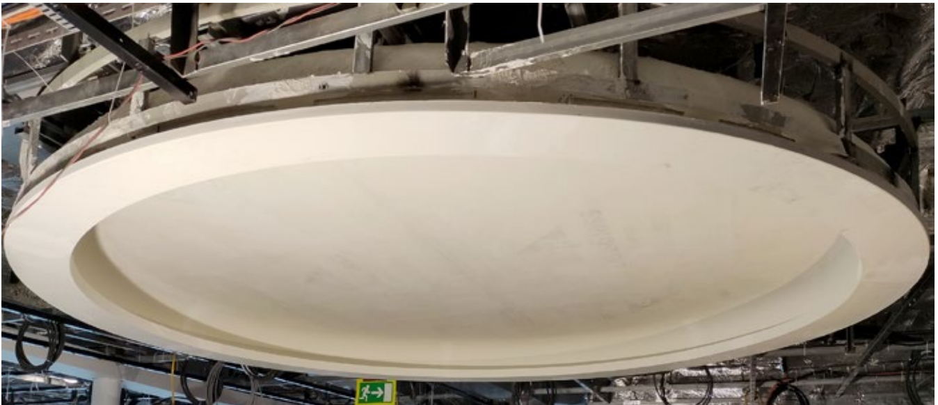
Levyn poikkisuuntaisesti levitetty CA120 liimakipsikerros, tasoittaa DGG-levyn pinnan aaltoilun.
